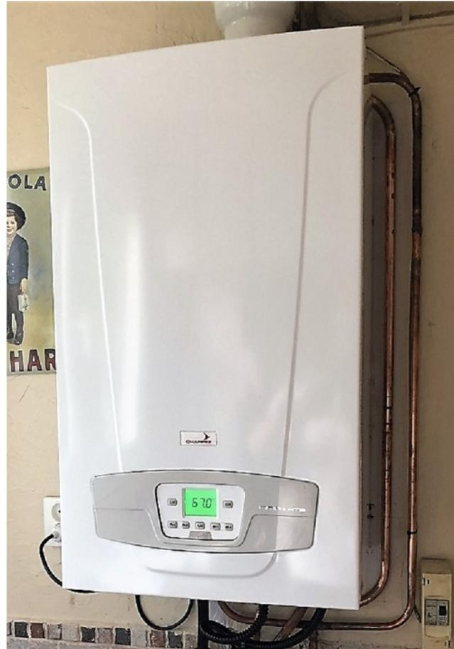
*Installation d'une chaudière gaz murale Chappée Initia plus HTE - 2,24 avec production eau chaude sanitaire. Remplacement d'une chaudière basse température VMC dans un immeuble*
